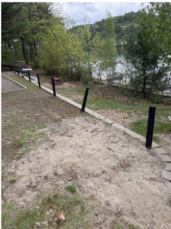
Hauteur de la balustrade insuffisante
