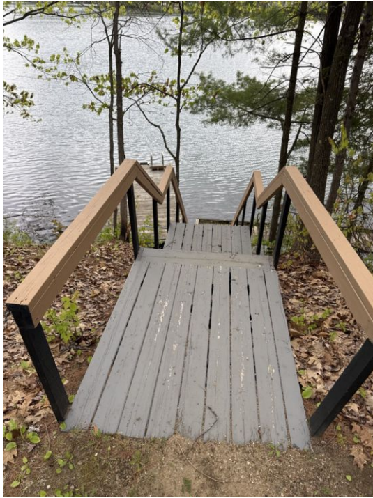
Hauteur de la balustrade insuffisante
